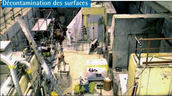
Décontamination des surfaces
