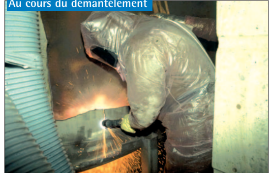
Au cours du démantèlement
