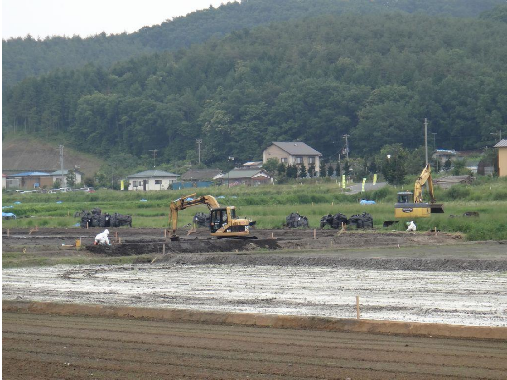
避難指示解除準備区域(飯舘村)における表土削り取り除染作業風景
