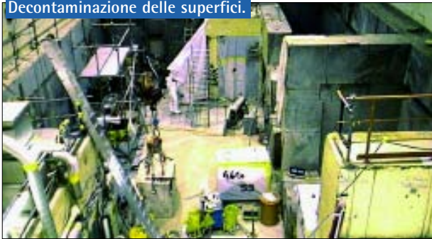
Decontaminazione delle superfici.
