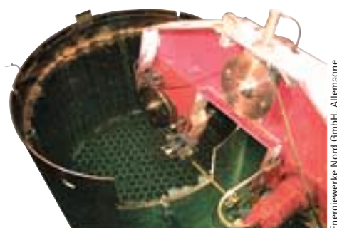
Cisaillage de la cuve du réacteur lors du démantèlement de Greifswald 5 en Allemagne.
