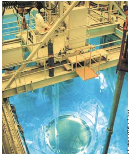
Remplacement d'éléments combustibles à la centrale nucléaire de Beznau en Suisse.
