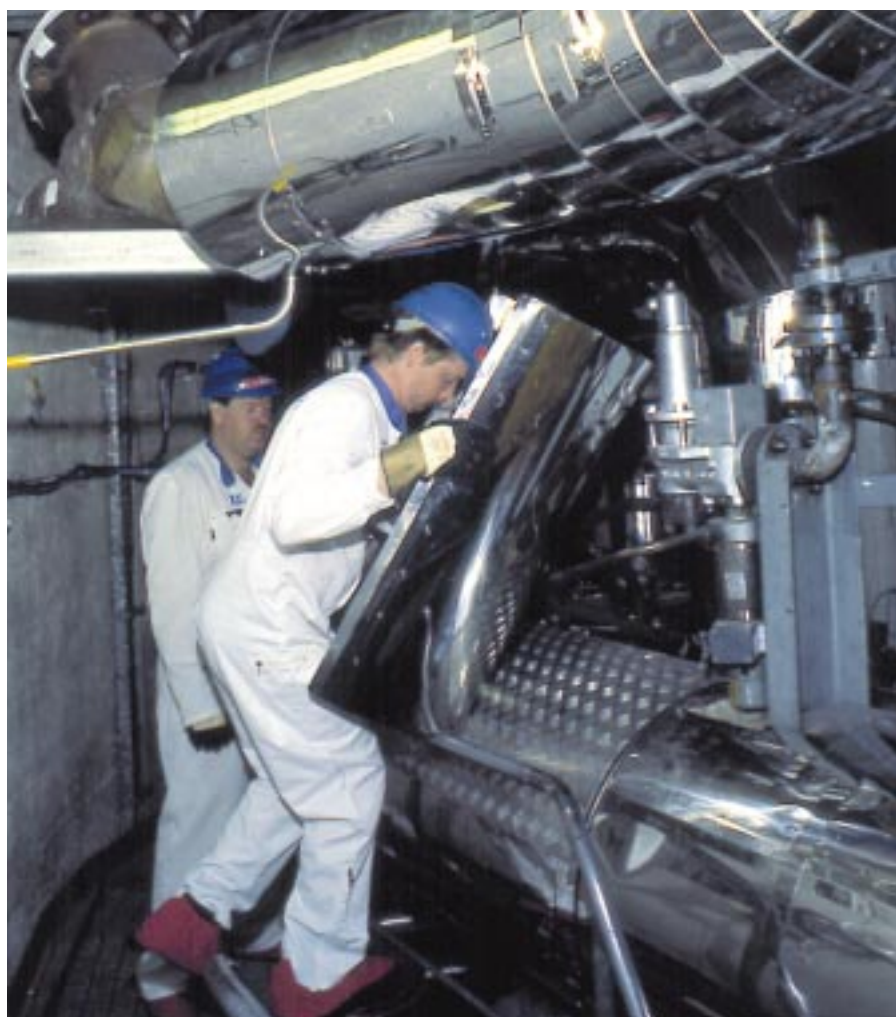
Les conséquences des ruptures de tuyauteries importantes dans les centrales nucléaires occupent une place de choix dans le retour d'expérience. Ci-dessus : des ouvriers posent l'isolant d'une tuyauterie essentielle.
