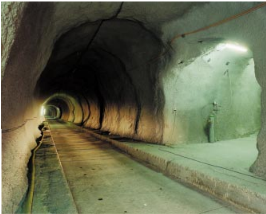
Laboratoire souterrain de recherche du Mont Terri, en Suisse, affecté à la caractérisation in situ de l'argile opalinus.
